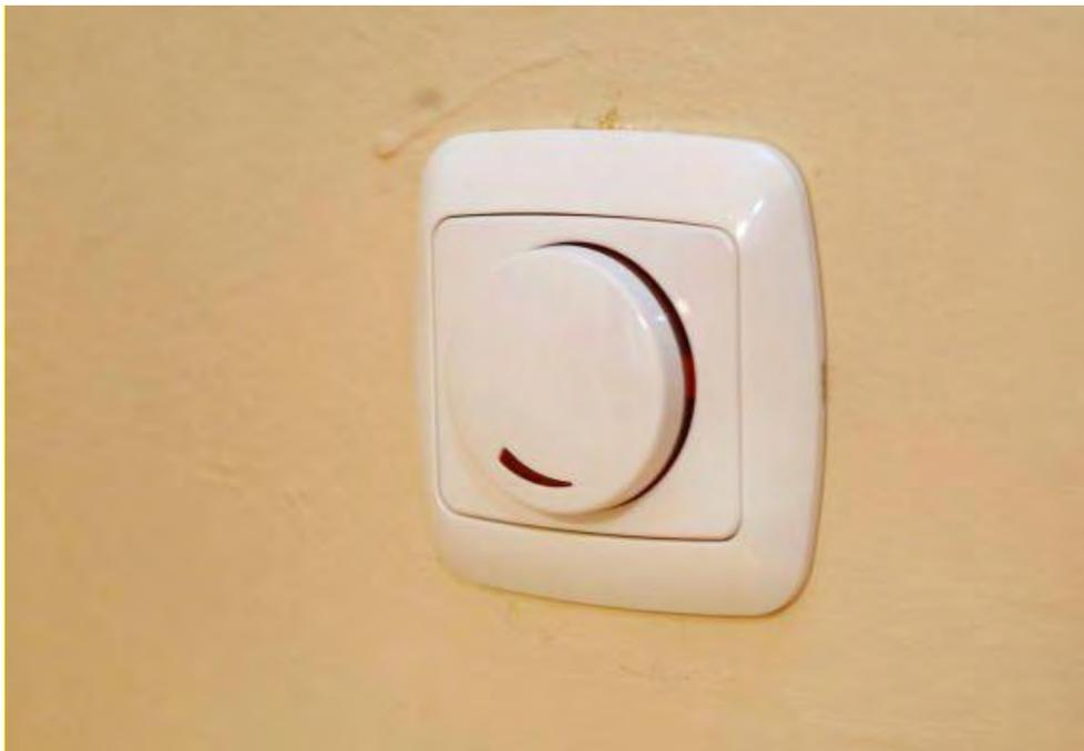
Fig. 9: Interruptor para graduar la intensidad de la luz.
