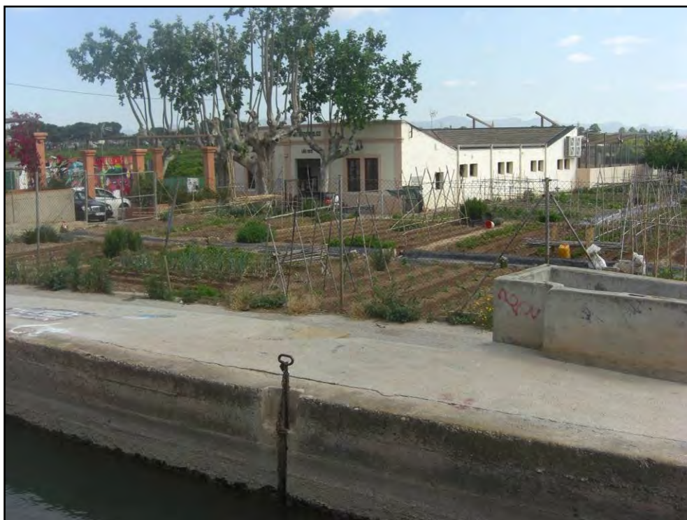
Edificios anexos - Vista desde la Real Acequia de Moncada
