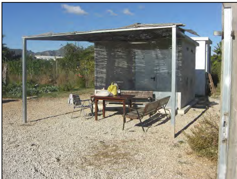
Zona de sombra y caseta de almacenaje de aperos
