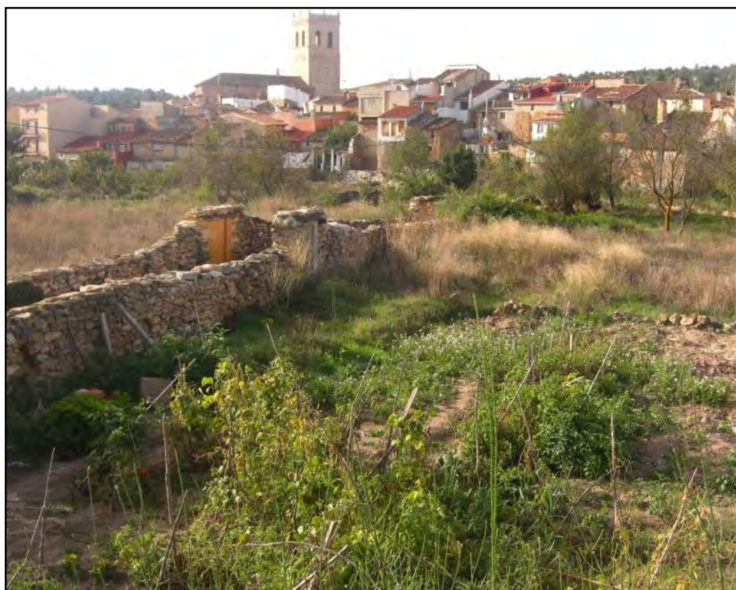
Vista del núcleo urbano
