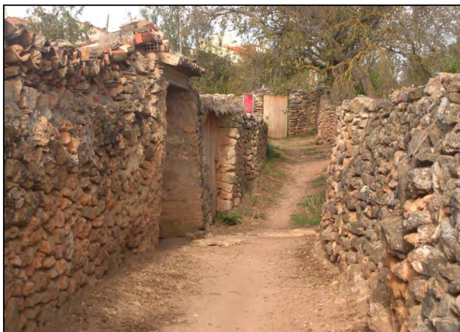
Detalle de tapias y puertas de madera de acceso a los huertos
