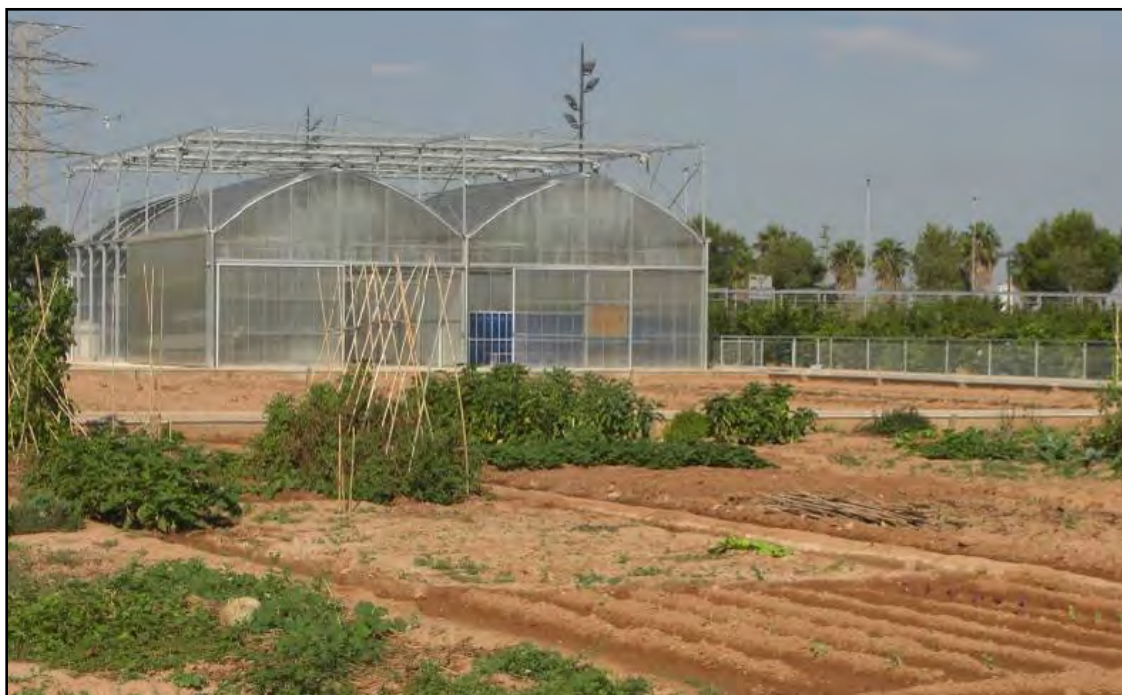
Vista del centro gestor del parque de La Torre
