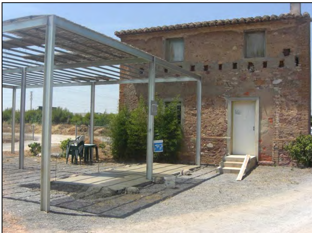
Caseta de aperos y lavabos y zona de sombra
