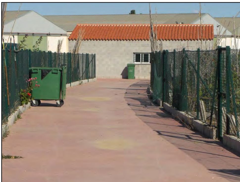
Vista del pasillo central, contenedores para la recogida de residuos y caseta para el almacenamiento de aperos
